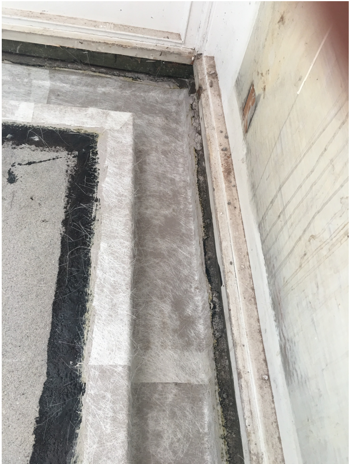
FlexJoint / Glasfiber i rende og lagt hen over isolering.
